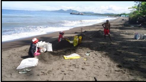
Gambar 19. Pemanfaatan endapan alluvial pasir pantai untuk material bangunan rumah setempat
